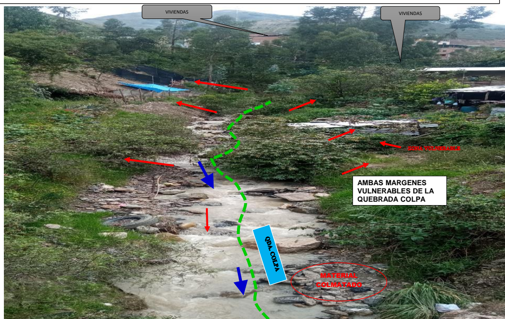
FIGURA N°01: TRAMO CRÍTICO EN LA QUEBRADA COLPA. AMBAS MARGENES EXPUESTOS A EROSION
